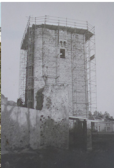
Le donjon en cours de restauration - 1985
