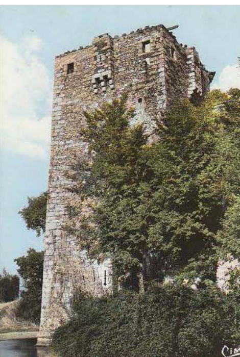
Le donjon après 1964 - toiture effondrée
