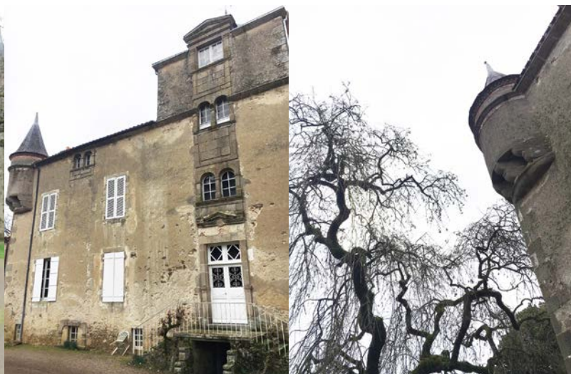
Façade principale du logis - 2019
