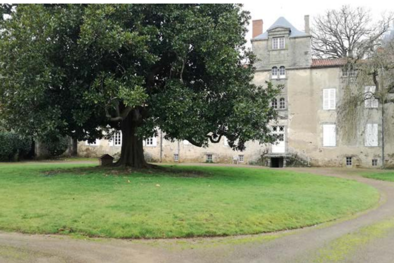
La cour intérieure et le logis - 2019
