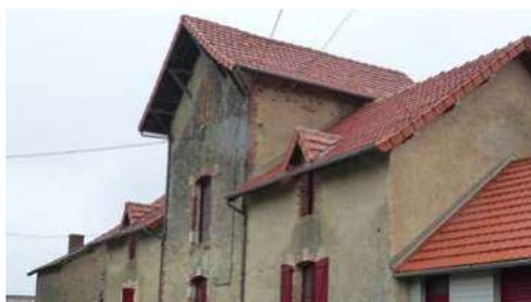
Couverture en tuiles plates losangées sur bâtiment agricole début XX<sup>ème</sup>.
