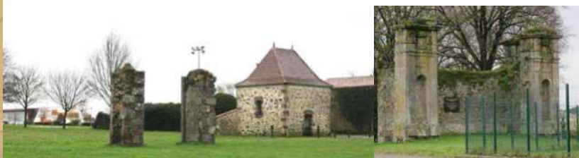
Vestiges des piliers marquant l'ancien axe l'Etendue - Ardelay 2013 (source : AVAP Les Herbiers - 2014)
