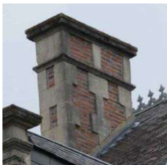
Cheminée en briques et pierres sur maison bourgeoise
