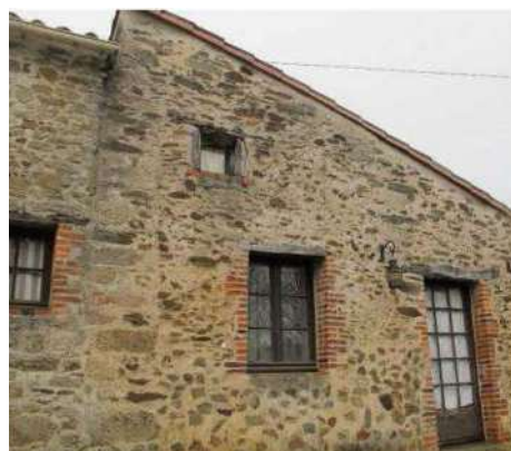
Enduit à pierre vue
