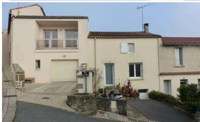
9. La couverture en enrobé des rues anciennes
