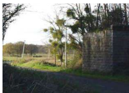
Base d'un pont de voie ferrée, Mouchamps - 2019
