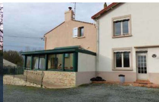
Une véranda en plastique, à larges montants, non cohérente avec la construction ancienne sur laquelle elle s'appuie.
