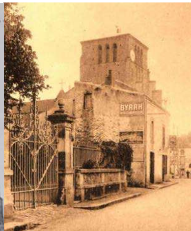
Eglise Saint-Pierre (Source : archives départementales)
