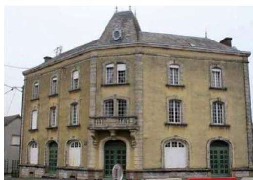
L'hôtel de la Gare transformé en appartements - 2013 (source : AVAP Les Herbiers - 2014)
