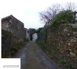
Mur de soutènement, rempart, mur de clôture
