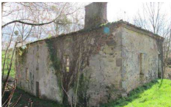
Moulin du Boistissandeau en ruines - 2013 (source : AVAP Les Herbiers - 2014)
