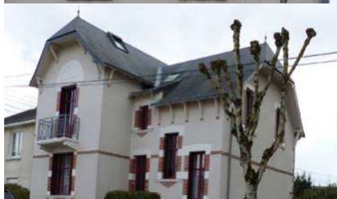
Couverture en ardoise sur maison bourgeoise XIX ème avec toiture à la Mansart et sur maison éclectique du début du XX ème siècle
