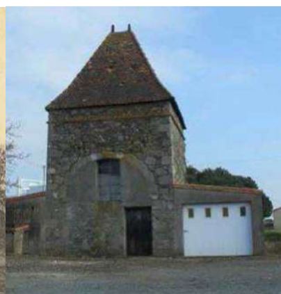
Pigeonnier et garage greffé 2013 (source : AVAP Les Herbiers - 2014)
