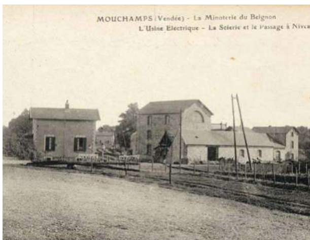
Usine Deverteuil à Mouchamps (Source : archives départementales)
