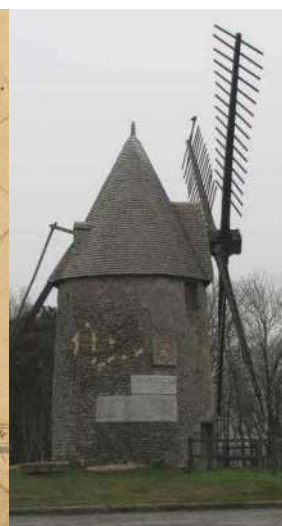
Moulin restauré - 2013 (source : AVAP Les Herbiers - 2014)
