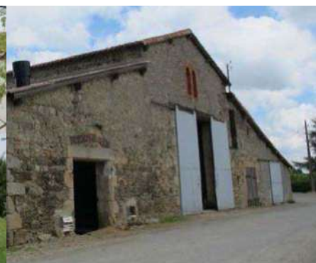
Grange de La Comaillère avec nef centrale - 2013 (source : AVAP Les Herbiers - 2014)
