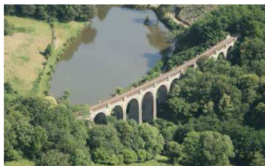
Viaduc de Coutigny (sources : Mairie des Herbiers)
