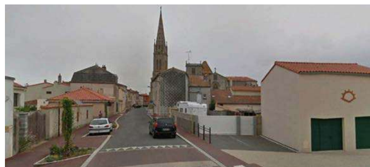
Un garage récent implanté en entrée du bourg d'Ardelay - 2019
