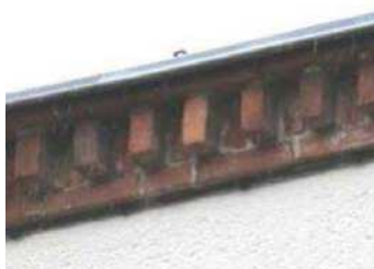
Corniche en briques à modillons
