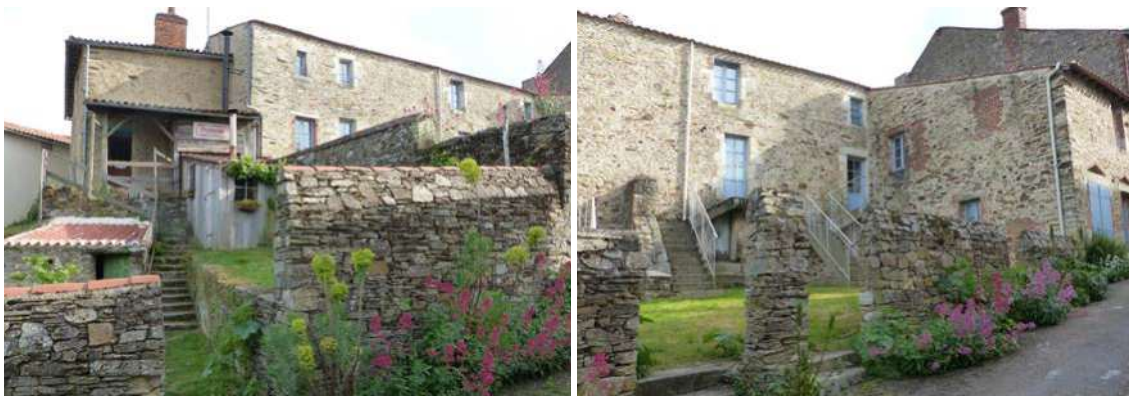
5 et 7 rue du Vieux Château - 2019
