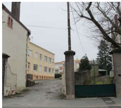
30 - 40 rue du Brandon - 2013 (source : AVAP Les Herbiers - 2014)
