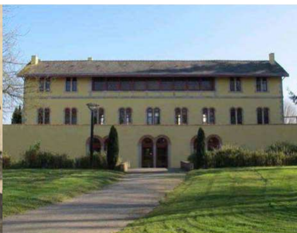
Bâtiment du lavoir transformé en salles communales - 2013 (source : AVAP Les Herbiers - 2014)
