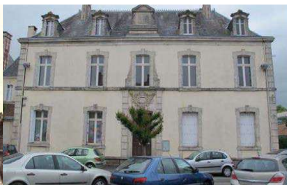
Ecole rue Saint-Blaise - 2013 (source : AVAP Les Herbiers - 2014)
