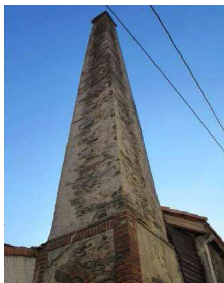
Cheminée de la tannerie - 2013 (source : AVAP Les Herbiers - 2014)
