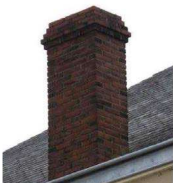
Cheminée en briques
