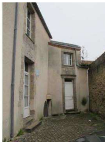
Le grand logis, la tour d'angle - 2013 (source : AVAP Les Herbiers - 2014)
