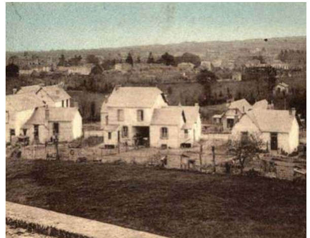
Les Herbiers, maisons ouvrières de l'usine Louis Rondeau (Source : archives départementales)
