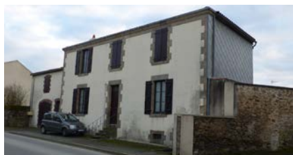
Mur ancien remplacé par du stationnement
