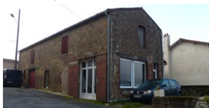
Pose de menuiseries standardisées sur une grange ancienne
