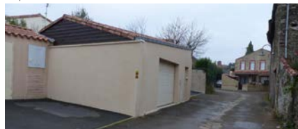
Des garages récents qui ne s'intègrent pas au tissu ancien (gabarit et matériaux employés)
