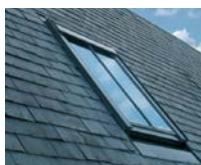
Châssis de toit intégré dans une toiture en ardoise
