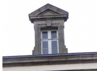
Lucarne à fronton, Les Herbiers (cliché Anne Boissay - architecte)
