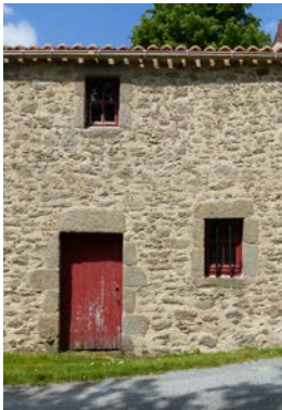
Façade ancienne non ordonnancée (cliché Anne Boissay - architecte)
