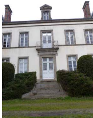
Façade ancienne ordonnancée (cliché Anne Boissay - architecte)
