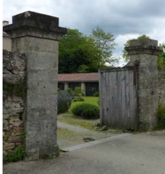
Ancien portail en bois (cliché Anne Boissay - architecte)
