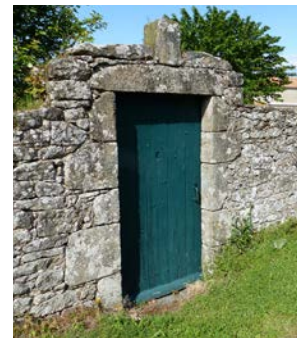
Porte piétonne dans un mur de clôture, encadrement en pierre, Beaurepaire (cliché Anne Boissay - architecte)
