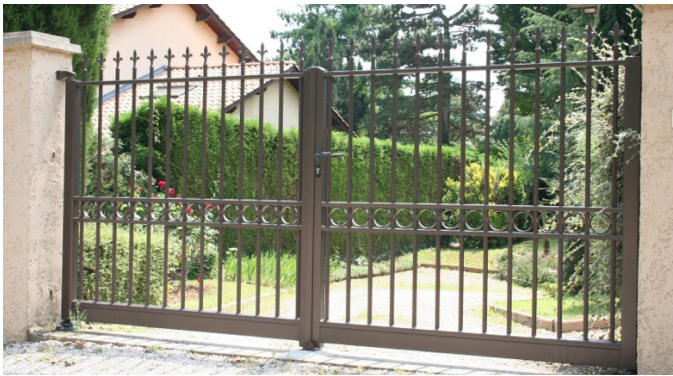
Portail récent de forme simple en ferronnerie
