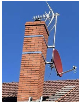
Parabole de teinte rouge sur cheminée brique et toiture tuiles
