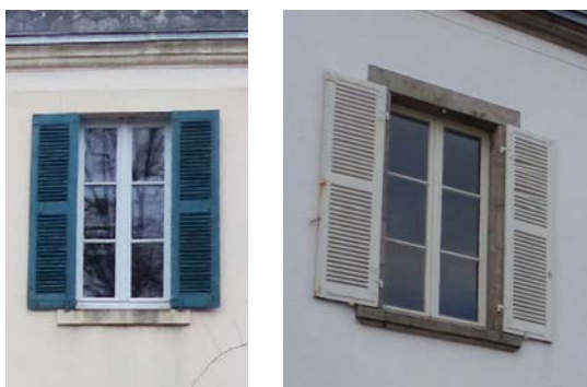
Fenêtres traditionnelles à 3 ou 4 carreaux par vantail, en bois avec petits bois extérieurs (cliché Anne Boissay - architecte)
