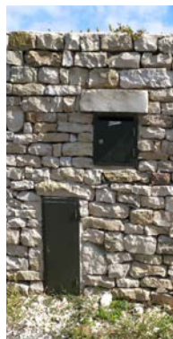
Coffrets dissimulés par un portillon en bois
