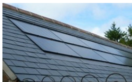
Panneaux sur couverture ardoises
