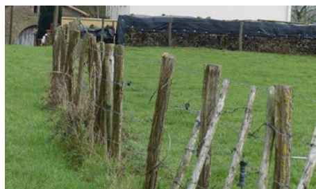
Clôture champêtre constituées de piquets bois et de fils métalliques
