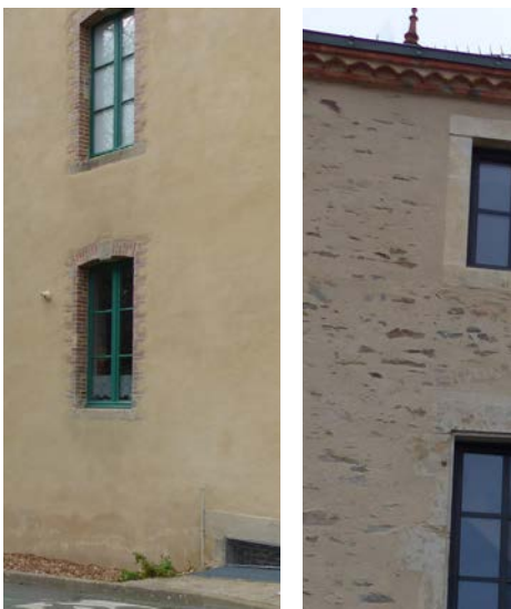
Façades de moellons recouverts d'un enduit chaux-sable.
