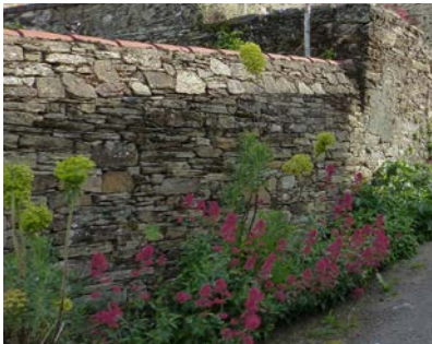
Murs hauts couronnés de tuiles tiges de botte (cliché Anne Boissay - architecte)
